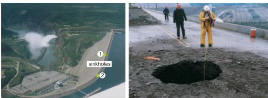
图 1-3 W.A.C. Bennett 大坝坝顶局部塌陷(Stewart and Garner, 2000)
