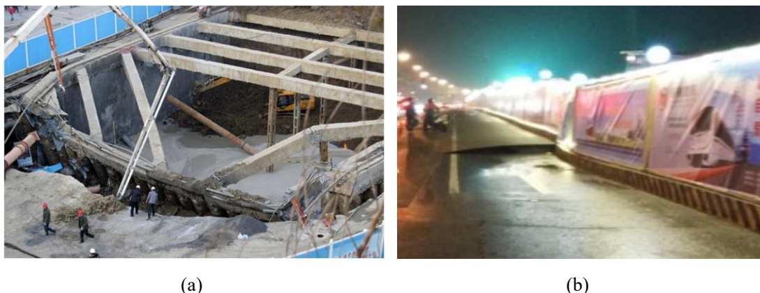
图 1-2 杭州地铁水澄桥站基坑(a)坑内渗蚀及(b)坑外地表沉降
